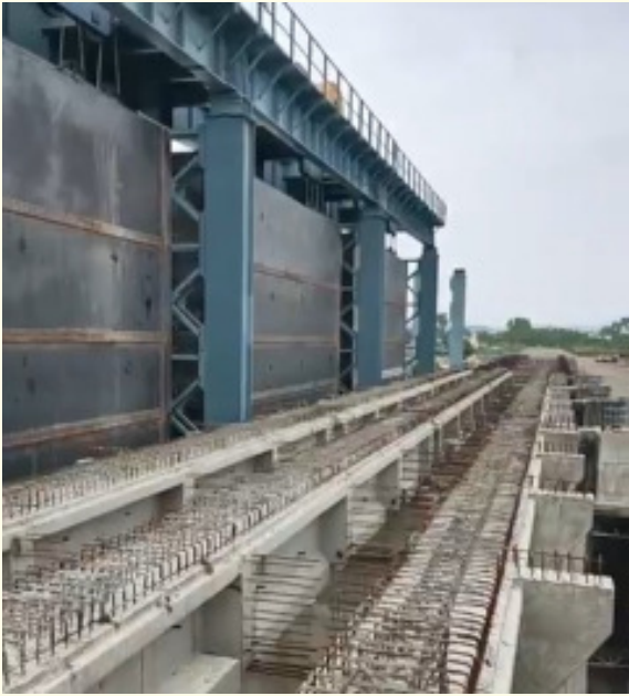
किनवट/प्रतिनिधी- किनवट शहरालगतच्या पैगंगानदीवरील निर्माणा-
